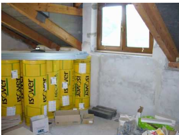
Místnost v podkroví 2. bytové jednotky
