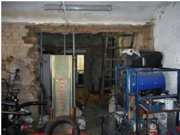
Provizorií vstu z dílny do 2.bytové jednotky
